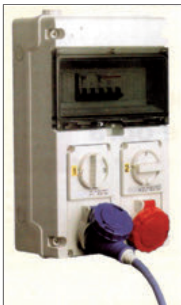
Figura 12. Cuadro auxiliar con diferenciales de alta sensibilidad.
