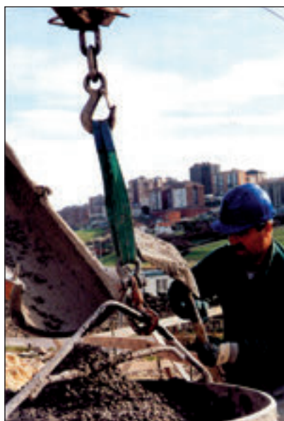
Figura 7. Eslinga aislante colocada entre el gancho y el elemento conductor a elevar, como medida adicional de seguridad
