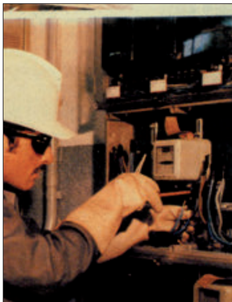
Figura 16. Los conductores deben revestirse a medida que avanza el trabajo, utilizando, por ejemplo, capuchones aislantes.
