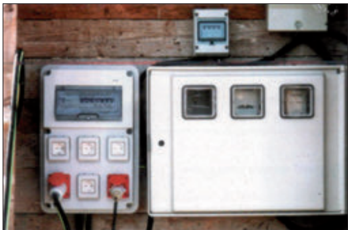
Figura 1. Cuadro eléctrico de obra, de material aislante.
