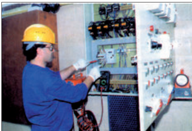
Figura 6. Comprobación de la ausencia de tensión.
