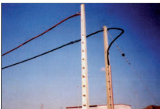
Figura. 4.- Red trenzada aislada para línea aérea de alta tensión ( U_n = menor o igual a 30 kV.).
