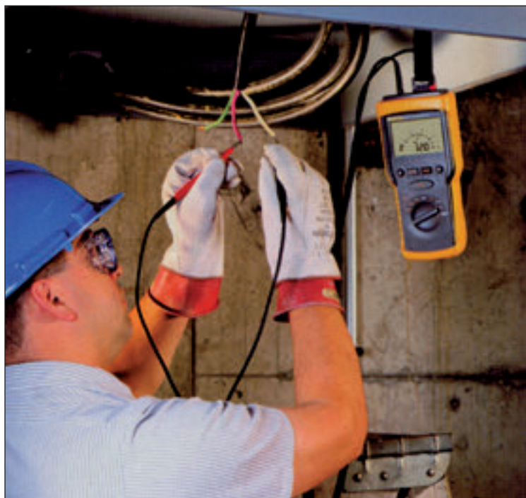
Figura 11. Comprobación y descarga e condensadores con tester. Las manos están protegidas.
