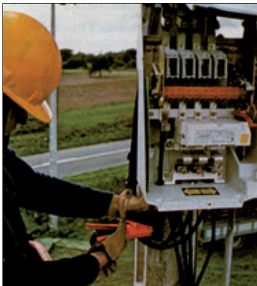
Figura 18. Preparativos para los trabajos en tensión. No se podrá realizar un trabajo en tensión mientras no exista un dispositivo de protección frente al cortocircuito (Atuómicos-Fusibles).
