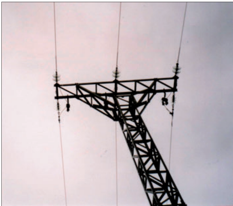
Figura. 7. Línea Aérea de Media Tensión 20 kV
