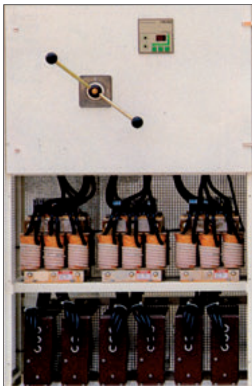
Batería de Condensadores trifásica.
