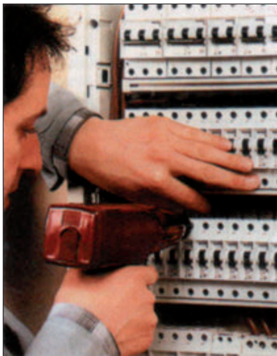
Figura 5. El aperellaje eléctrico a instalar debe tener un grado de protección IP 20 como mínimo.
