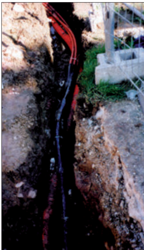
Figura 12. Cables de alta tensión en zanja
